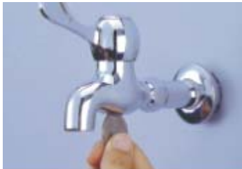
圖二 水龍頭下方凹槽之水量調整鈕
