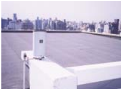
▲ 凸版印刷株式會社採用雨量計控制初期雨水之排放
