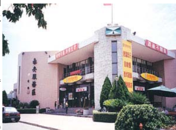
▲ 泰安休息站為中山高速公路南來北往的主要中繼站，盥洗室用水使用量驚人。
