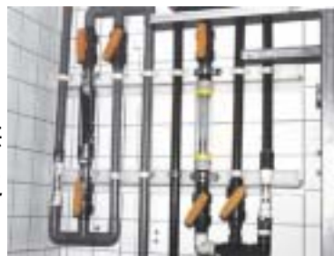
▲電鍍用水各進水管路裝設自動流量平衡閥，以控制水壓水量。
