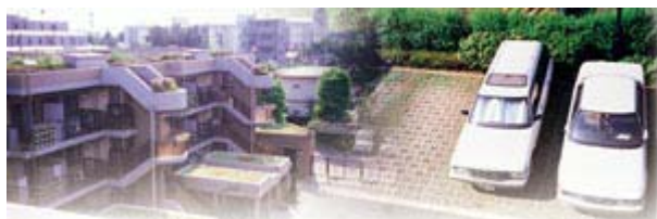
▲圖 15 室外停車場設透水磚
