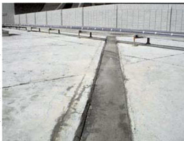
▲大面積屋頂明溝截流，增加排水速度（花蓮慈濟醫院）
