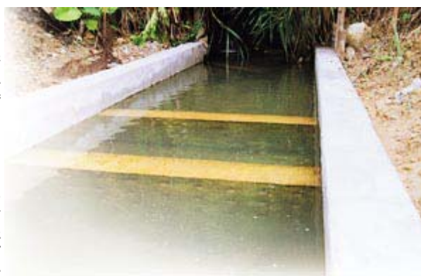
▲集流渠道設置整流板，避免紊流產生 地面收集
