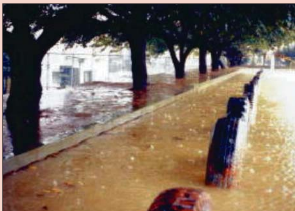
學校的暴雨雨水貯留設施
