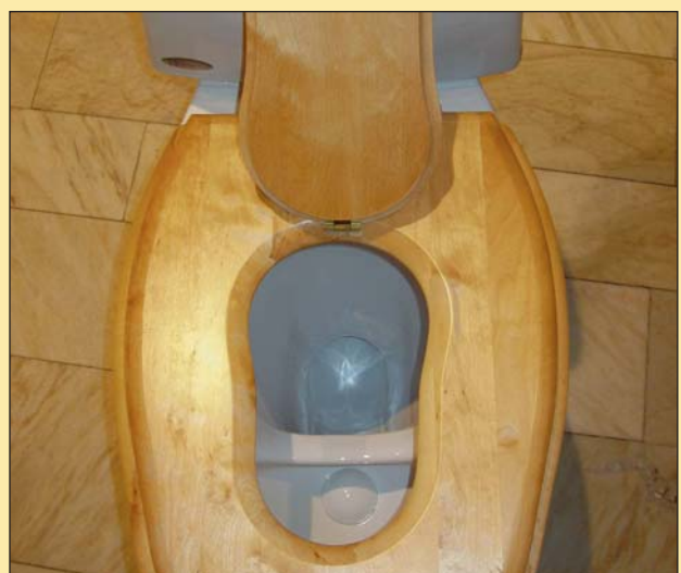
「聰明廁所」的前面的小號用，後面的供大號使用，比一般產品節水60%以上。
