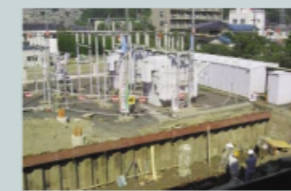
電力設備更新工事
