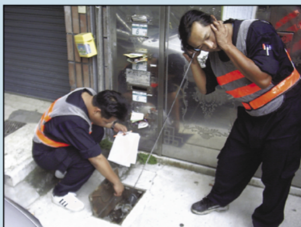
圖1 於水表處實施聽音法測漏
