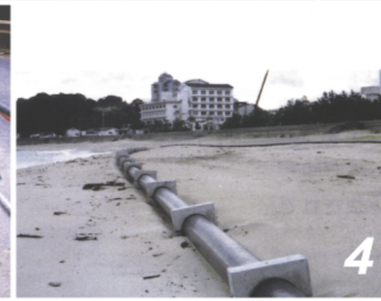
圖1 海濱安定化工法實驗送水管（日本茨城縣） 圖2 餘熱利用配管 圖3 柳井地域廣域水道企業團配水管（日本山口縣） 圖4 鳥羽市相差淨化放流管布設工事（日本三重縣）
