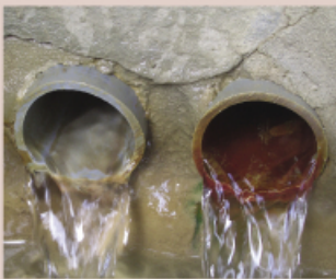
(a) 管線腐蝕輕微
