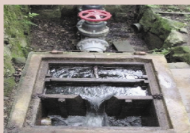
日本箱根溫泉明渠流量計 (三角堰)
