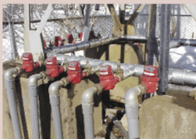
北海道阿寒湖溫泉計量設備 (葉輪式流量計)
