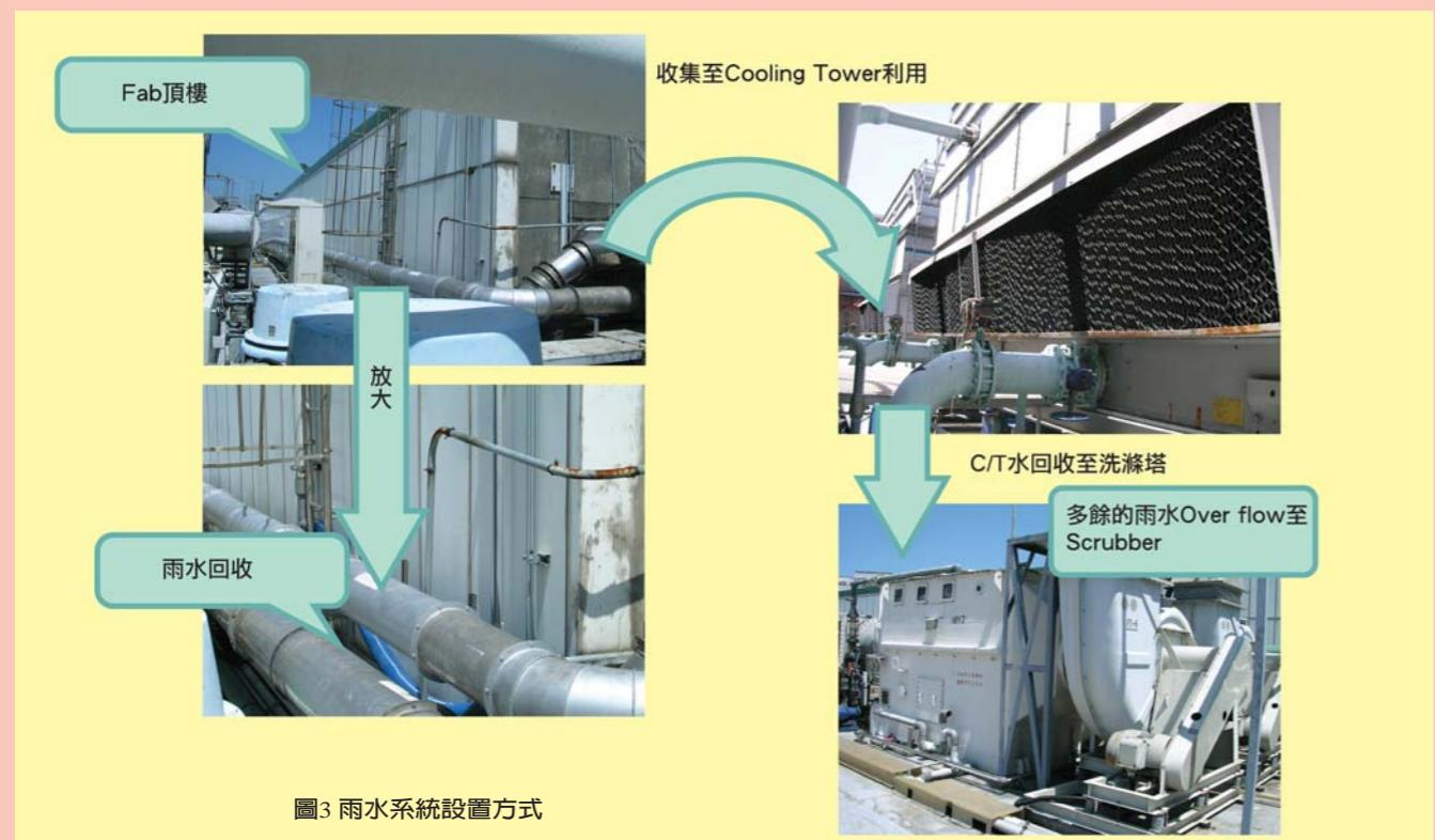
圖3 雨水系統設置方式
