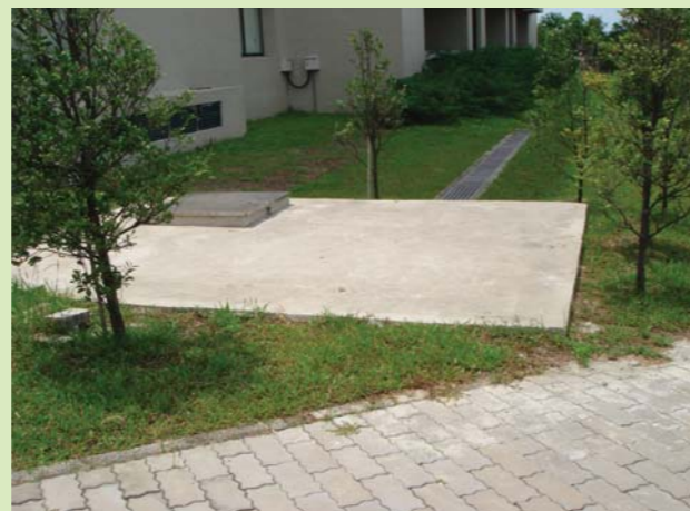
高雄大學雨水RC貯槽
