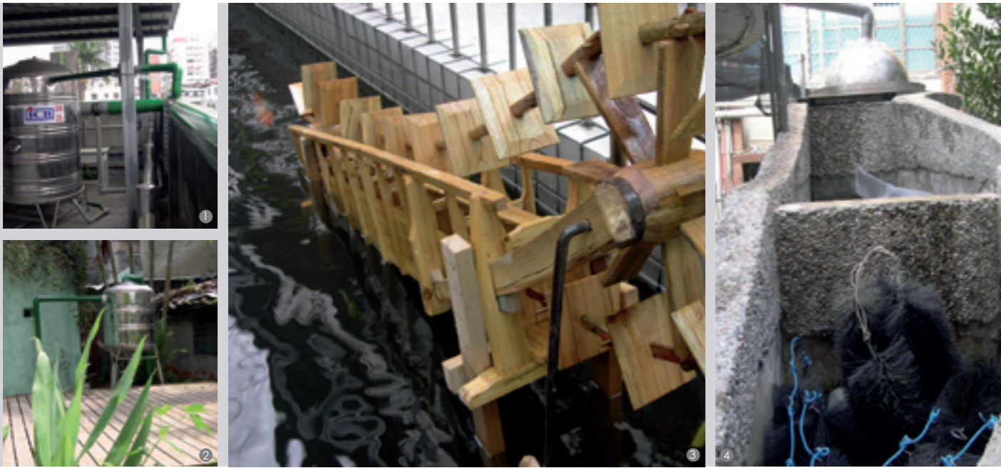
圖1 2.屋頂回收利用6吋管儲水增加安全性及儲水量 圖3.龍骨水車 圖4.魚池生態過濾
