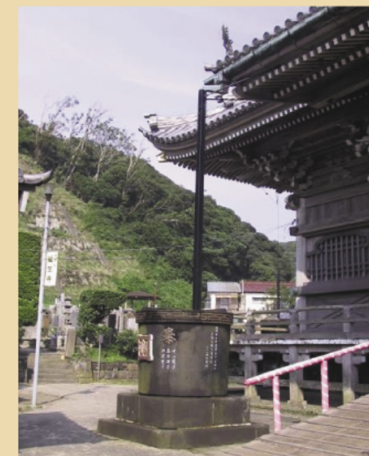
圖5 日本寺院利用屋頂雨水利用的情形
