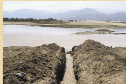
圖6 石嘴山市卻正在挖地造湖的情形
