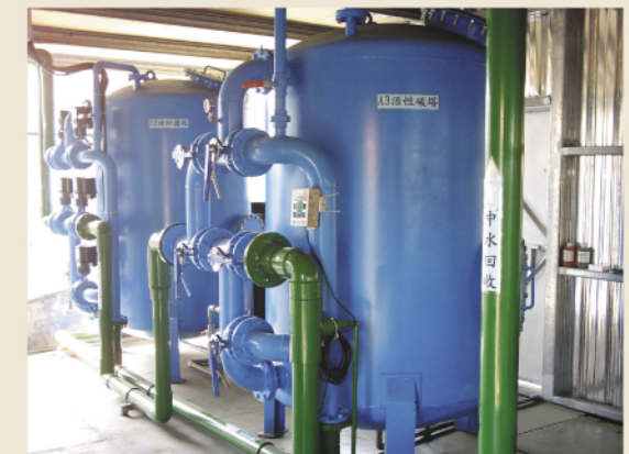
圖11 玉里榮民醫院利用原有污水處理廠所建造的100噸中水處理貯槽，將污水廠之放流水回收再利用於澆灌及景觀用水
