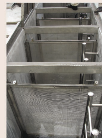
圖4 雨水物理處理之三層篩網設計
