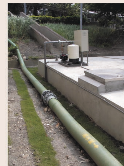
圖3 80噸地下式大型雨水貯留槽
