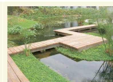
圖十一 生活污水處理回收再利用
