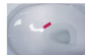
水封水高度標示測試情形
