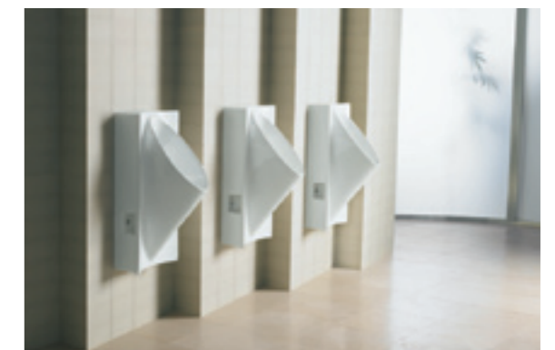
圖五 免沖水小便器安裝實例
