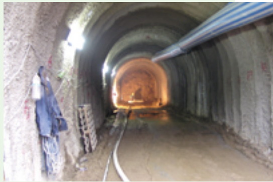
輸水隧道施工
