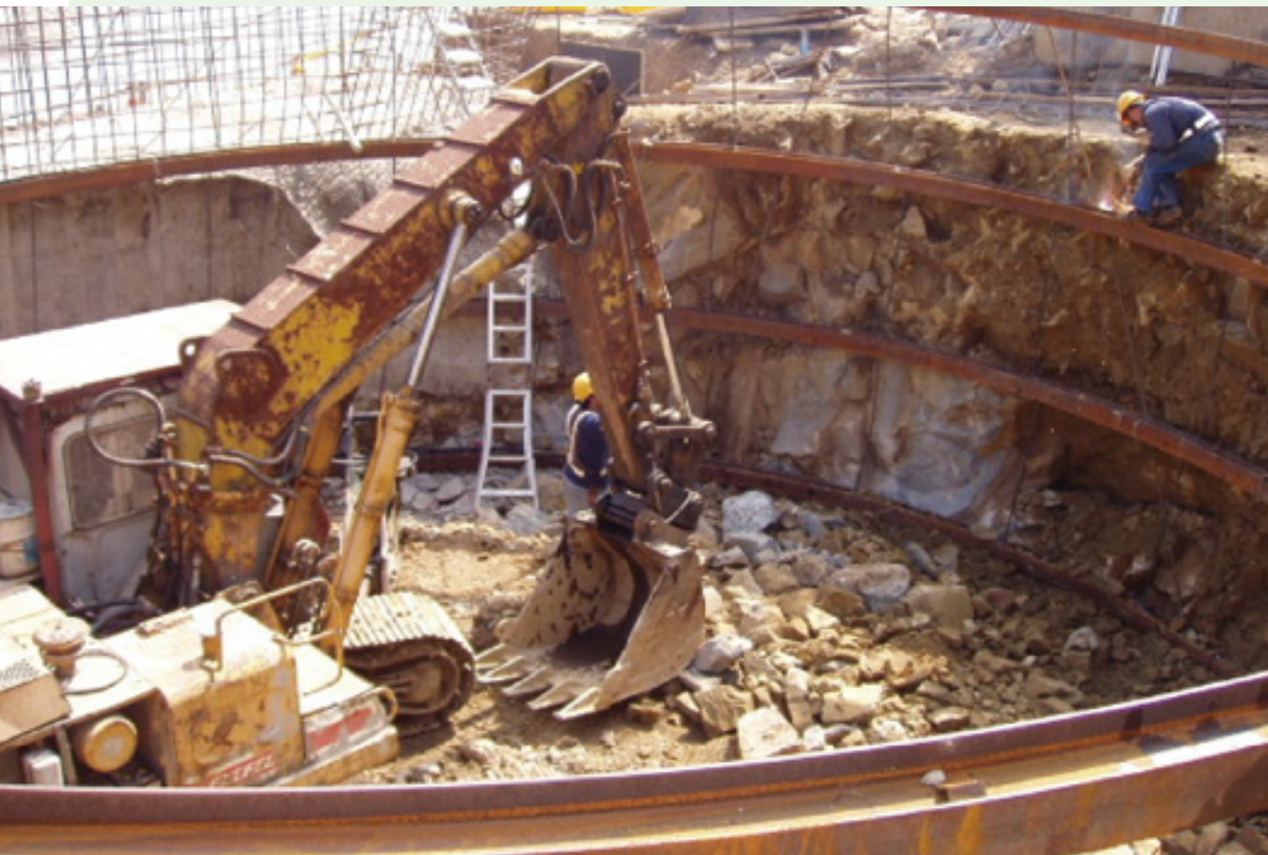
取水豎井施工
