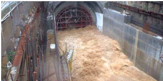
93.09.11 分洪隧道入口處
