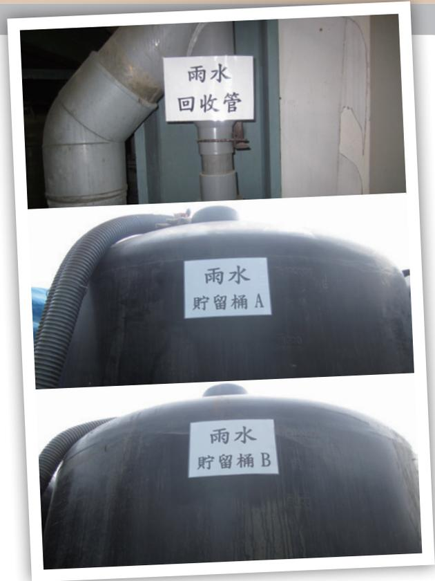
使用，用以提供現場製程上所需要的次級用水，相對的也減少了自來水的進廠使用量，可節省自來水量約月平均 90 噸，達到節能再利用的目的。
