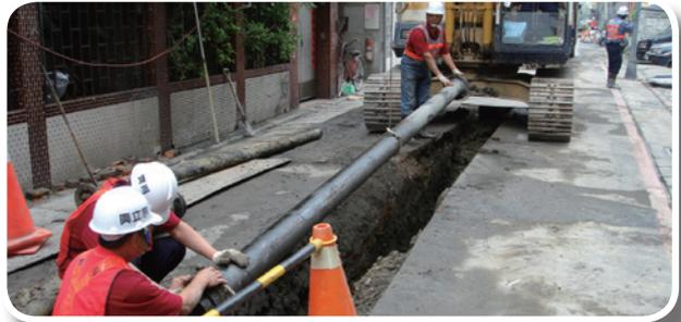
輸配水管已有 82% 換成延性石墨鑄鐵管 DIP
