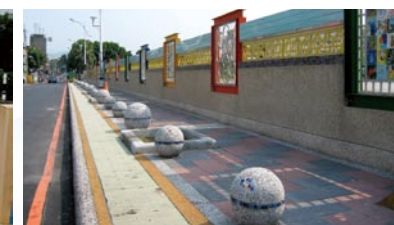
圖7 板橋市大觀國中（水溝蓋及人行道）
