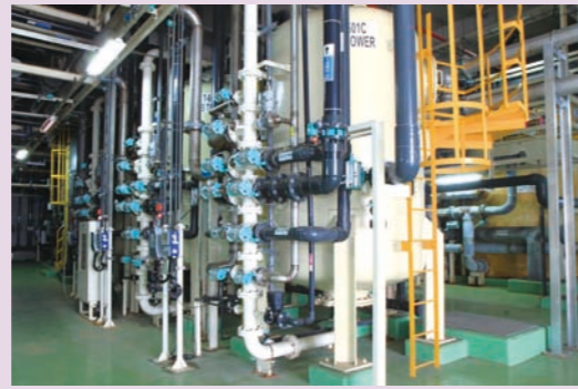
圖三 MBP混床樹脂塔系統延長MB再生週期
