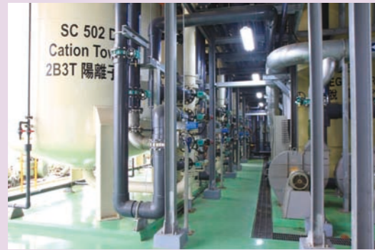
圖二 增設2B3T系統，減輕RO及MB系統運轉負荷
