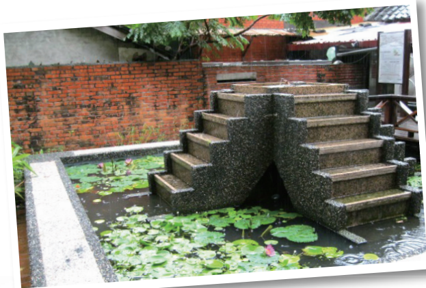
圖五 雨水儲留引用至生態池
