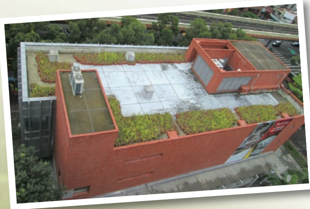
圖六 雨水回收使用至樓頂花台澆灌
