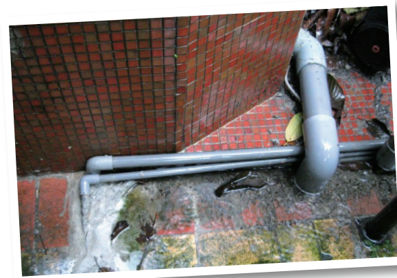
圖八 學生宿舍水管檢漏及施工
