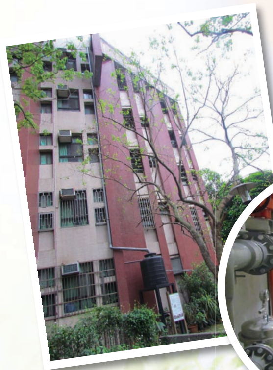
圖三 由屋頂接引雨水至中途儲水桶
