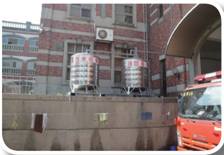
圖 5. 設立消防儲水槽
