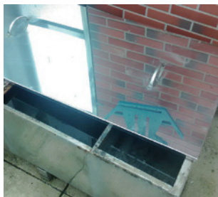
圖 11. 設置節水儲槽
