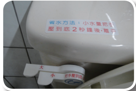
圖 6. 馬桶換裝二段式沖水器
