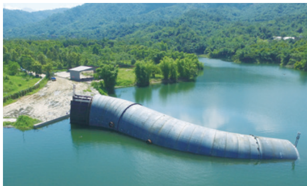
曾文水庫防淤隧道象鼻鋼管組裝空照
