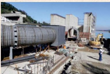
100.4 排砂隧道分歧鋼管環形鋼筋綁紮
