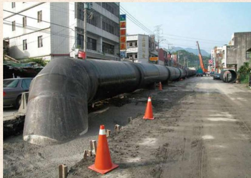
後池緊急抽水作業 - 抽水機組及輸水管線布設（大黑龍）
