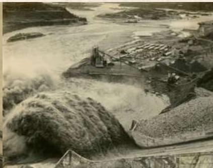
溢洪道溢洪，後池右岸護岸被沖損情形
