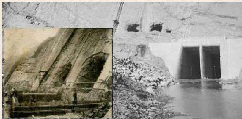
電廠壓力鋼管開鑿情形（右下為導水隧道入口）
