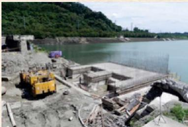
99.10 排砂隧道挑流工基礎混凝土完成
