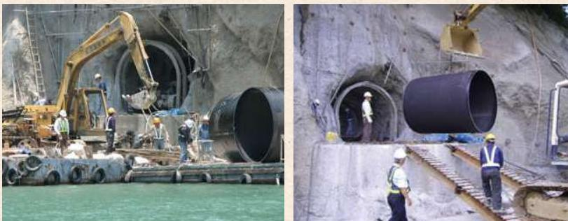
上層取水口破鏡段開挖及鋼管安裝
