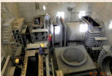
101.1 排砂隧道水工機械組立及高壓閘門與射流閘門安裝
