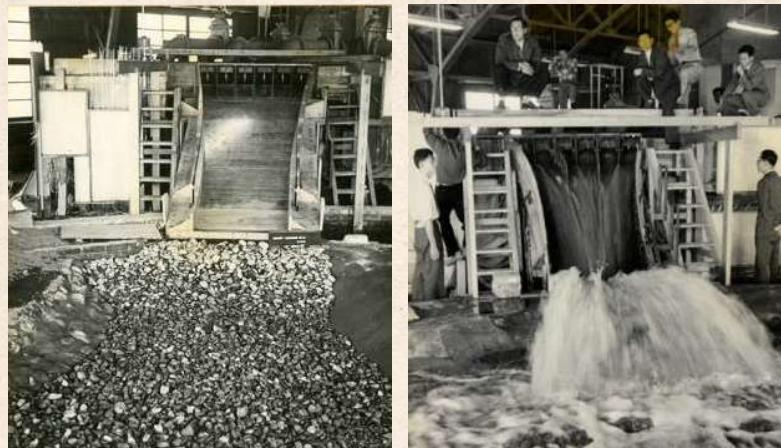
溢洪道水工模型試驗 (49 年 1 月、模型比例尺 1 : 60)
