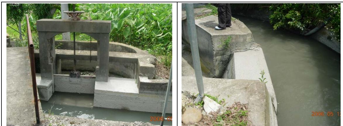
圖4-4-5 大甲溪內埔圳溢流設施照片
